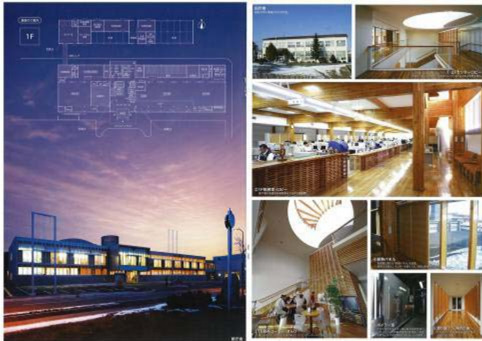
完成足寄町庁舎
